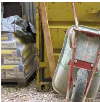
Lagerstätte für Baumaterial
