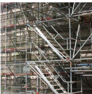
Gerüst an der Rückseite des Asamgebäudes
